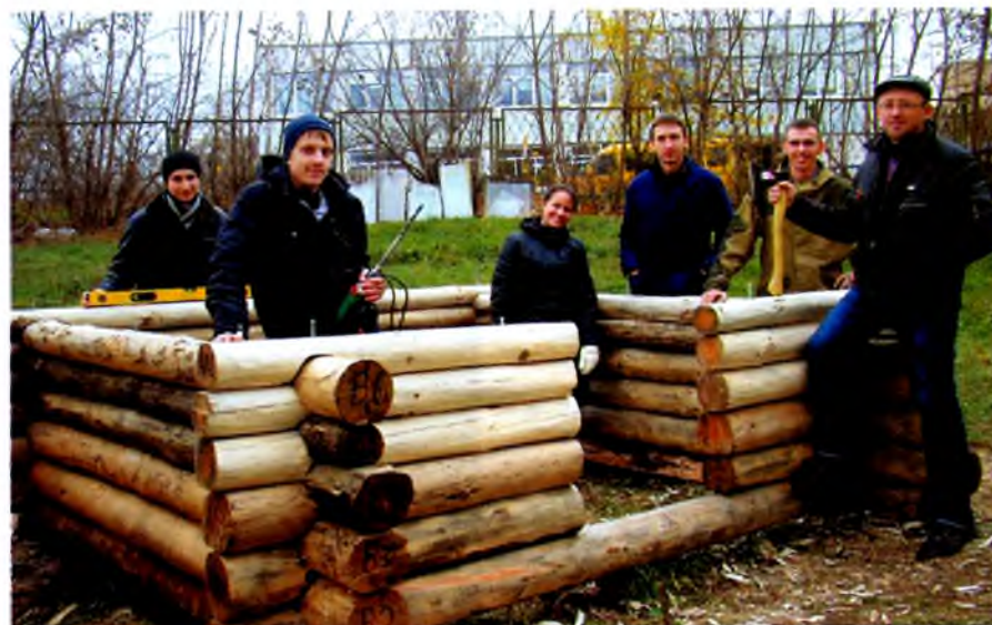
Студенты на практическом занятии по технологии деревянного домостроения
